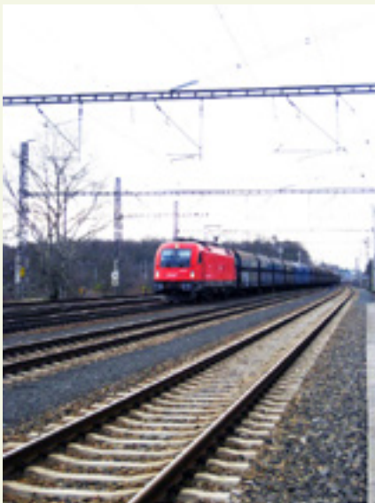
Foto 2 – Ein Güterzug passiert den sanierten Eisenbahnknoten in Břeclav (Tschechische Republik)
